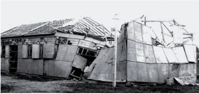
Vom Wirbelsturm beschädigte Scheune auf dem Gelände der Deckstation
